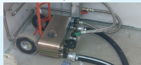
Plattenwärmetauscher zur Systemtrennung
