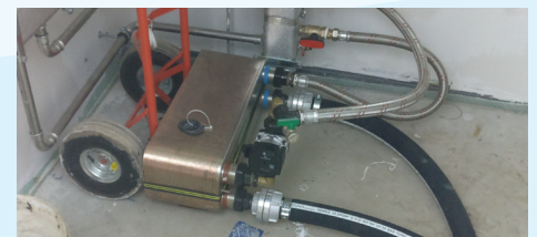
Plattenwärmetauscher zur Systemtrennung
